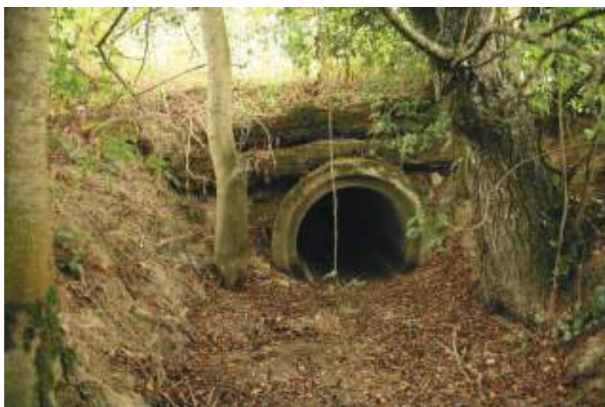
Franchissement existant en aval de la E12 sur l'affluent du Souveron
